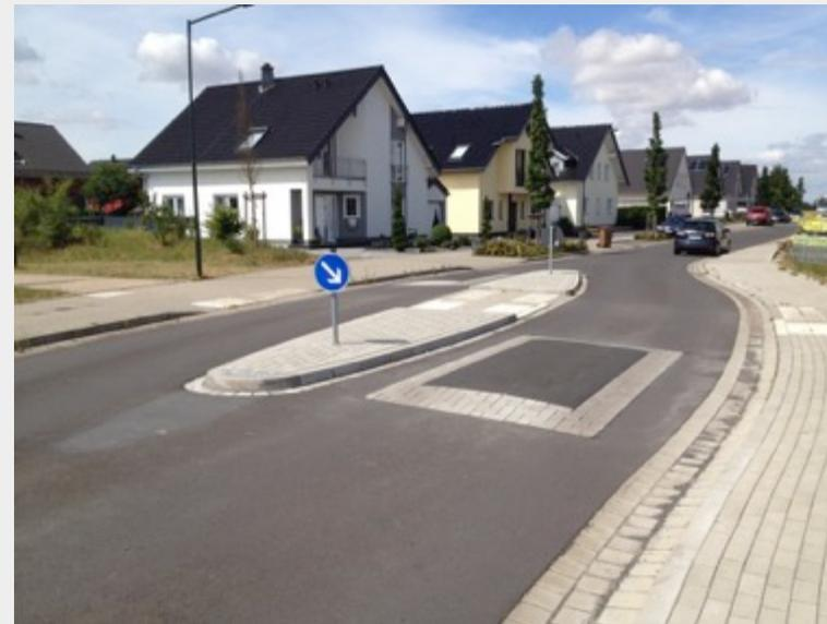
nachgerüstete Fahrbahnkissen zur Geschwindigkeitsreduzierung
